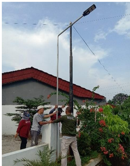
Gambar 8. Pemasangan lampu tenaga surya
