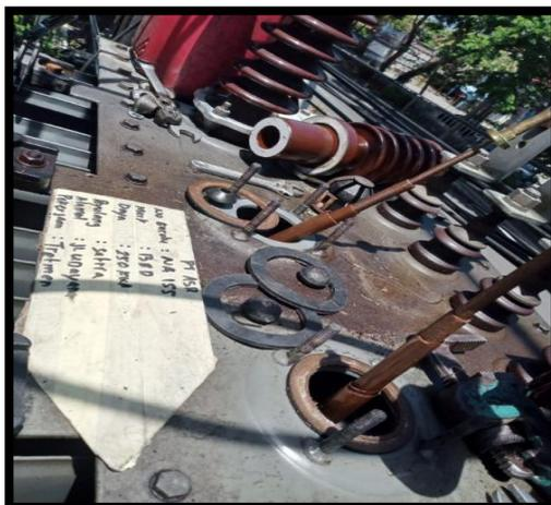
Gambar 12. Penggantian Seal/Packing Trafo
