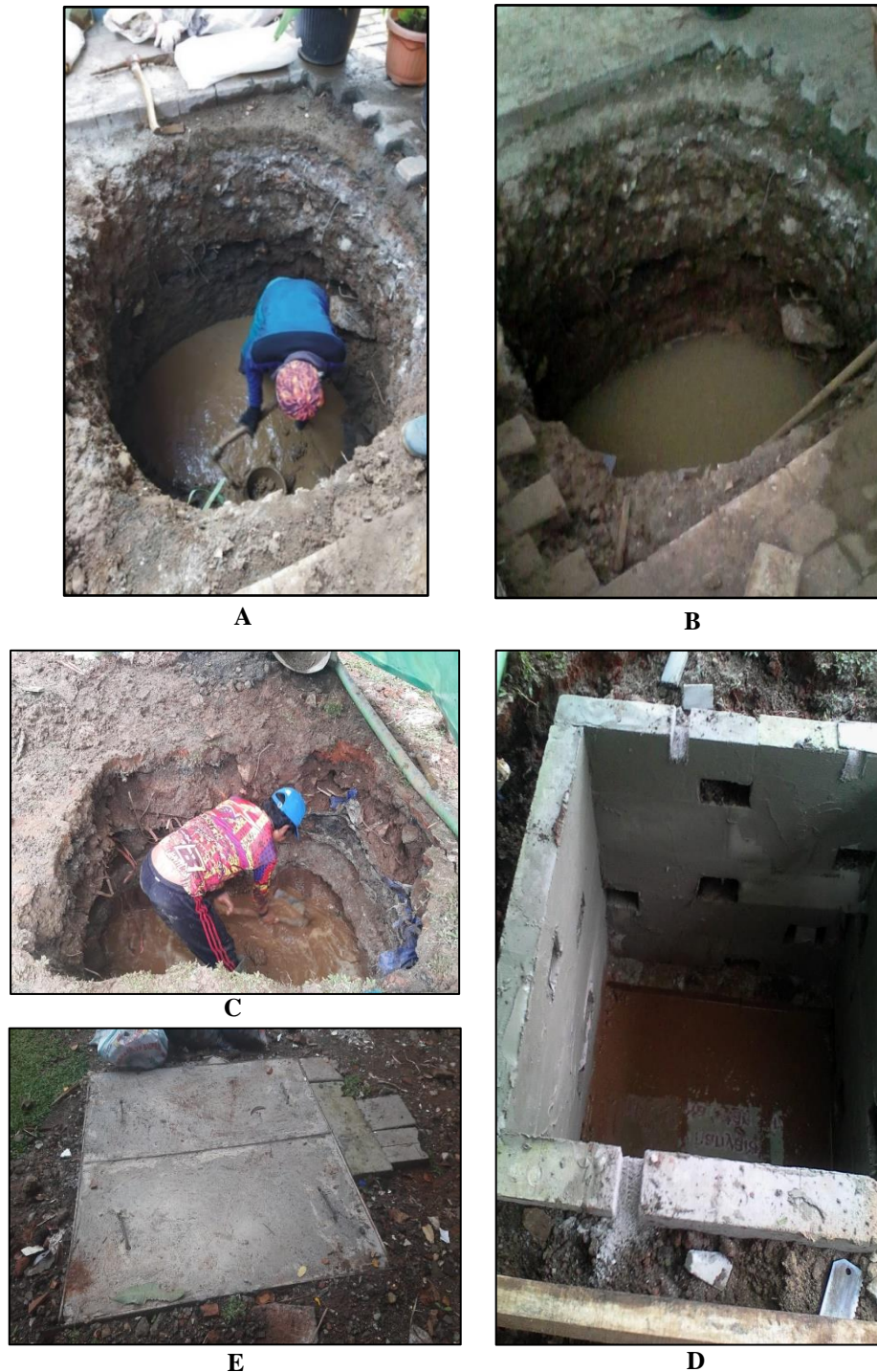
Gambar 4. (A) Peggalian sumur resapan. (B). Lubang sumur resapan yang kontak dengan muka air tanah, (C) Peggalian sumur resapan lokasi kedua, (D). Pemasangan dinding hebel. (E). Pemasangan penutup sumur resapan
