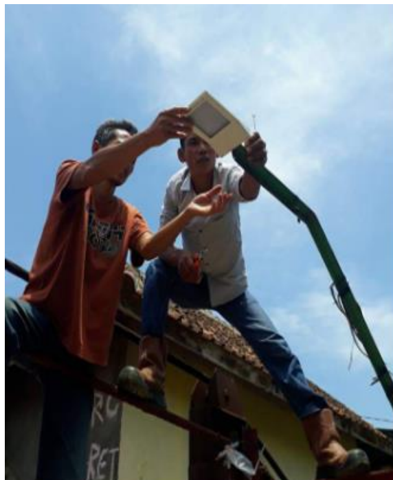
Gambar 4. Pemasangan Lampu pada Titik 1 Jembatan
