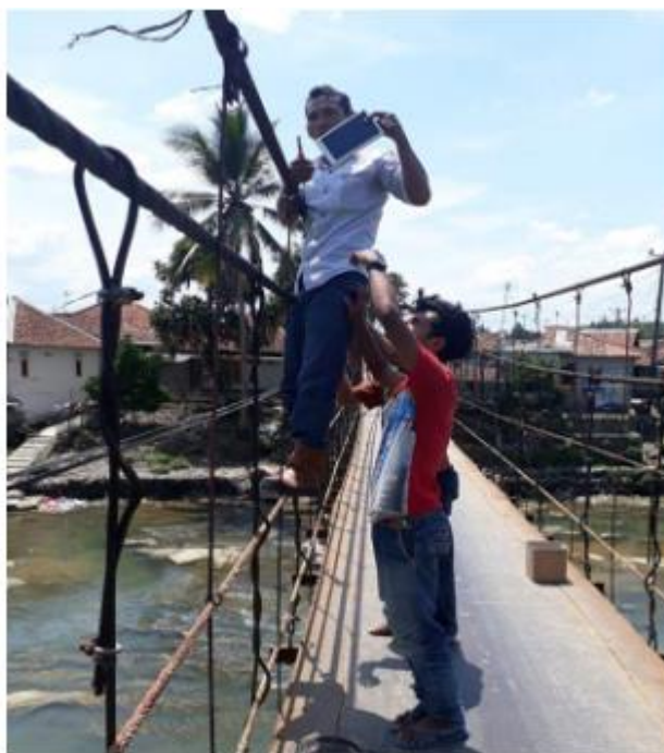
Gambar 5. Pemasang Pemasangan Lampu Surya Pada Titik 3 Jembatan
