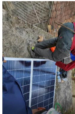
Gambar 12. Pemasangan Modul Surya Tahap 2 Sumber : Dokumentasi Pribadi
