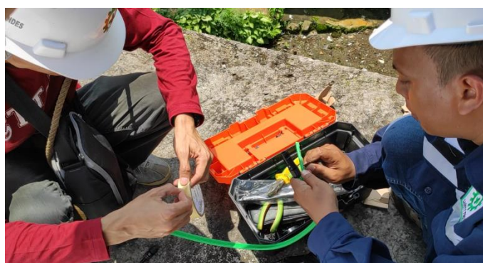
Gambar 13. Pemasangan Instalasi Listrik Modul Surya Sumber : Dokumentasi Pribadi
