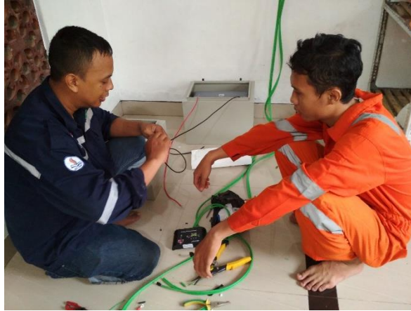
Gambar 14. Pemasangan Solar Charge Controller dan Battery Sumber : Dokumentasi Pribadi
