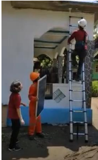
Gambar 11. Pemasangan Modul Surya Tahap 1 Sumber : Dokumentasi Pribadi
